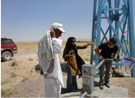
Visite de terrain, zone de construction d'un point d'eau potable.
